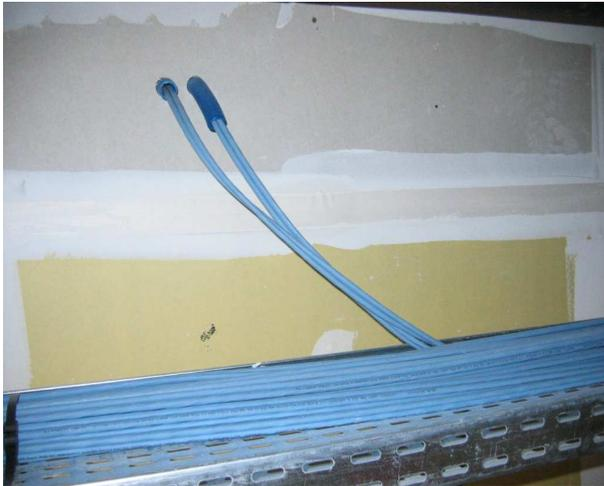
Une fois le câble passé dans la pièce, il faut le faire descendre en bas du mur où se situera la prise terminale. Donc pour cela, il faut faire passer le câble derrière la cloison en plaquo.
