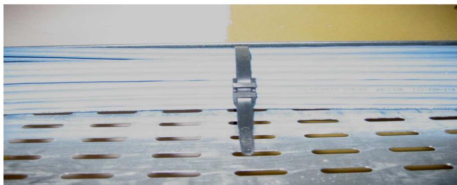
Donc maintenant les câbles tirés, il faut faire passer les câbles dans leurs pièces respectives. Il faut utiliser le plan pour savoir à quel endroit doit se situer les prises dans les pièces, donc ensuite il faut percer le mur au dessus du chemin de câbles et à peu près en ligne droite de la prise à l'aide d'une visseuse (si cloche).
